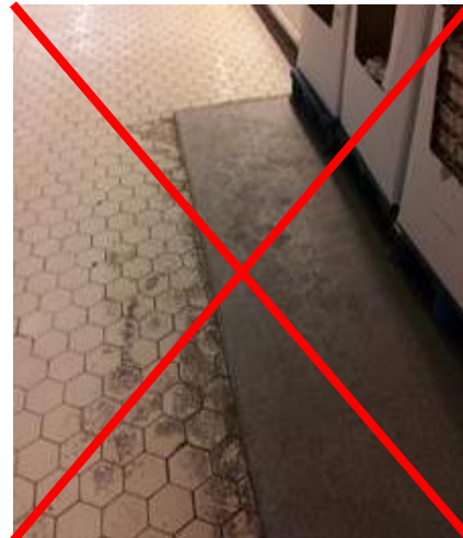
nicht geeigneter Bodenbelag
