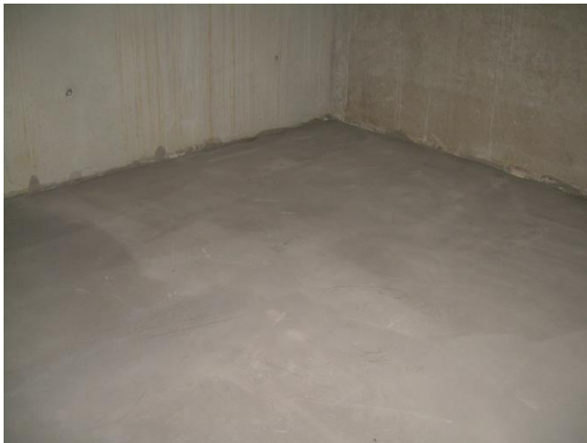
glatter, geeigneter Untergrund aus Betonestrich
