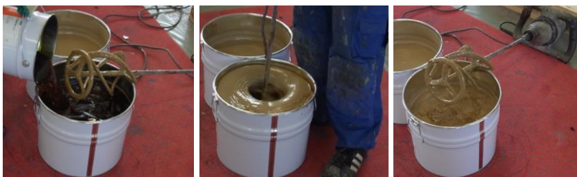
Anrühren des 2-Komponenten PU-Klebers
